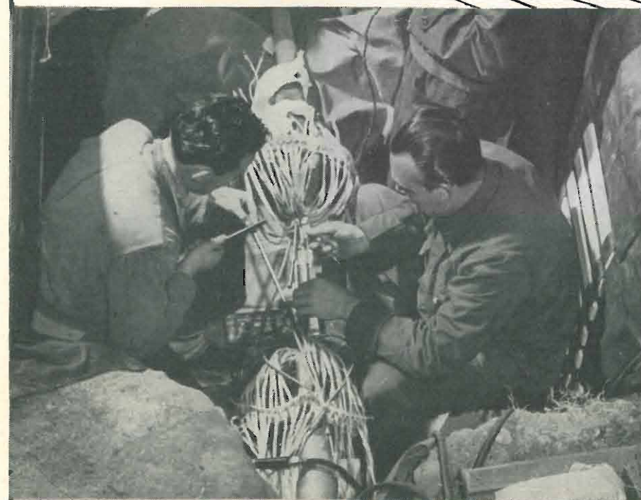
ESECUZIONE DI GIUNTO SU CAVO COASSIALE
